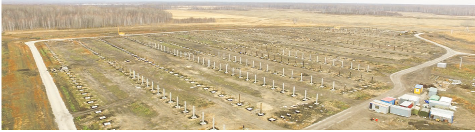
Начало строительства 3-й очереди свинокомплекса АО «Кудряшовское» на площадке в Кольвани
